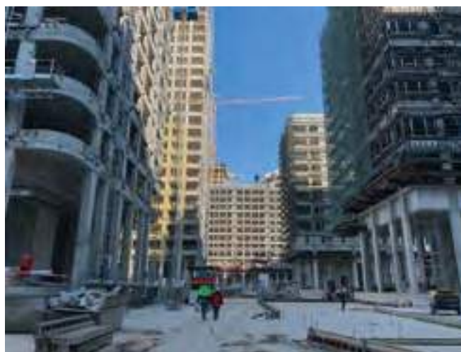
ЖК «ОСТРОВ». Введен в эксплуатацию напорный трубопровод для ливневой канализации.
