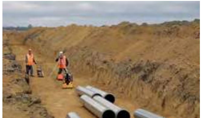
Монтаж напорного коллектора.
